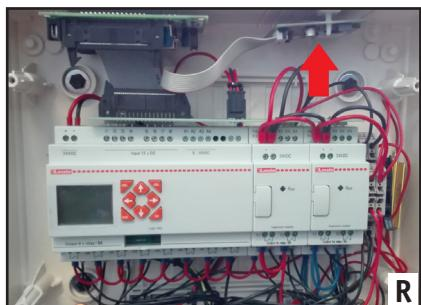
**4)** Tenere premuto sul pulsante SW1 del modulo radio del ricevitore fino a quando il led LD1 non lampeggia (**fig. T**). Se i due led smettono di lampeggiare la configurazione è terminata.
